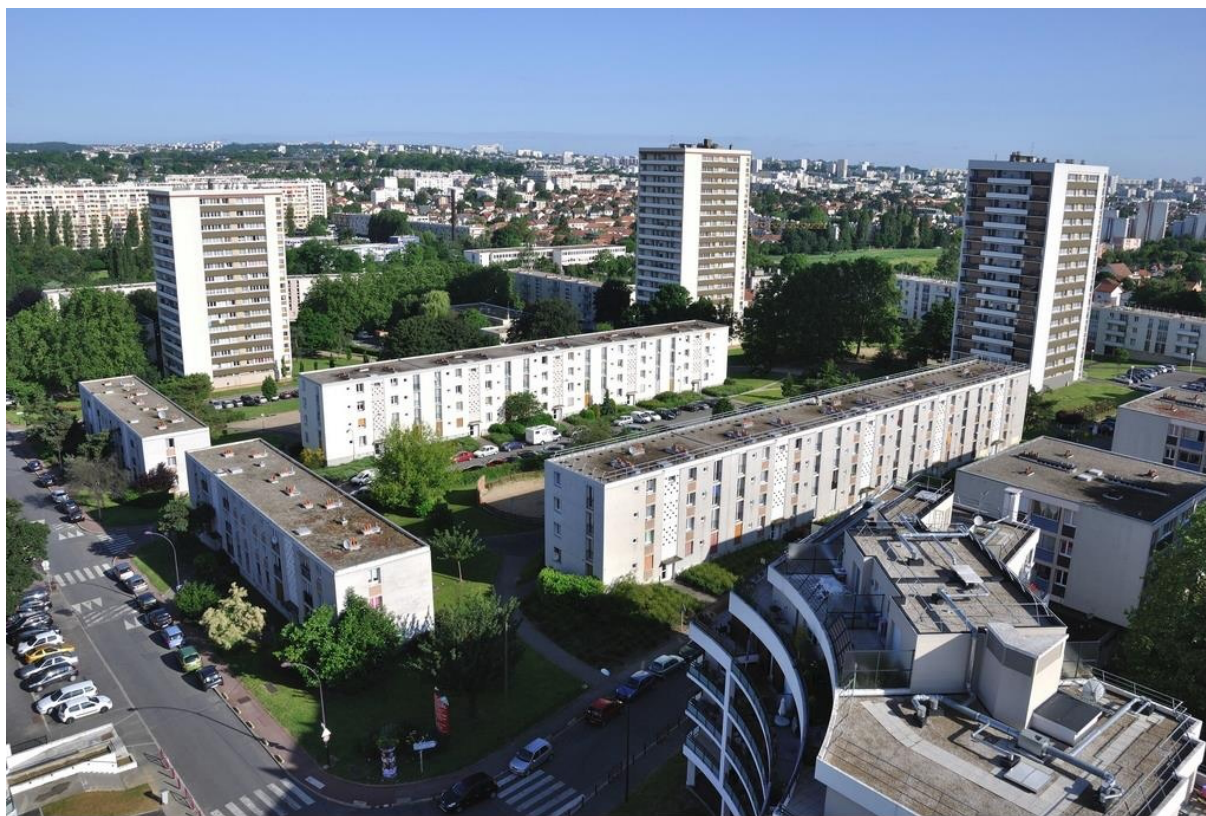
Figure 1 : Lotissement « Vallée aux Renards » à L'Haÿ-les-Roses
