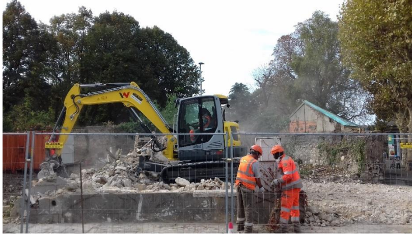
Démolition du 10 rue des tournelles
