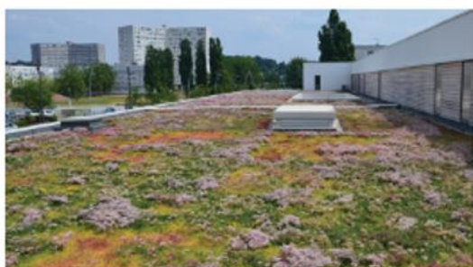
Exemple de toiture végétale extensive simple
