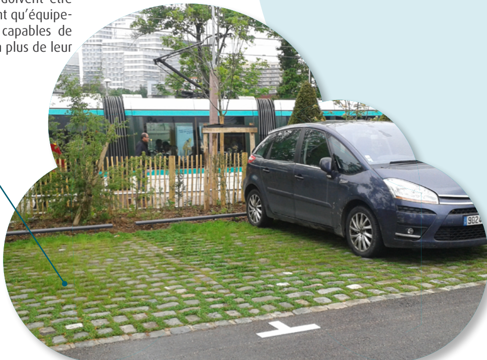
Parking infiltrant évitant l'imperméabilisation, Fresnes (DRIEE)
