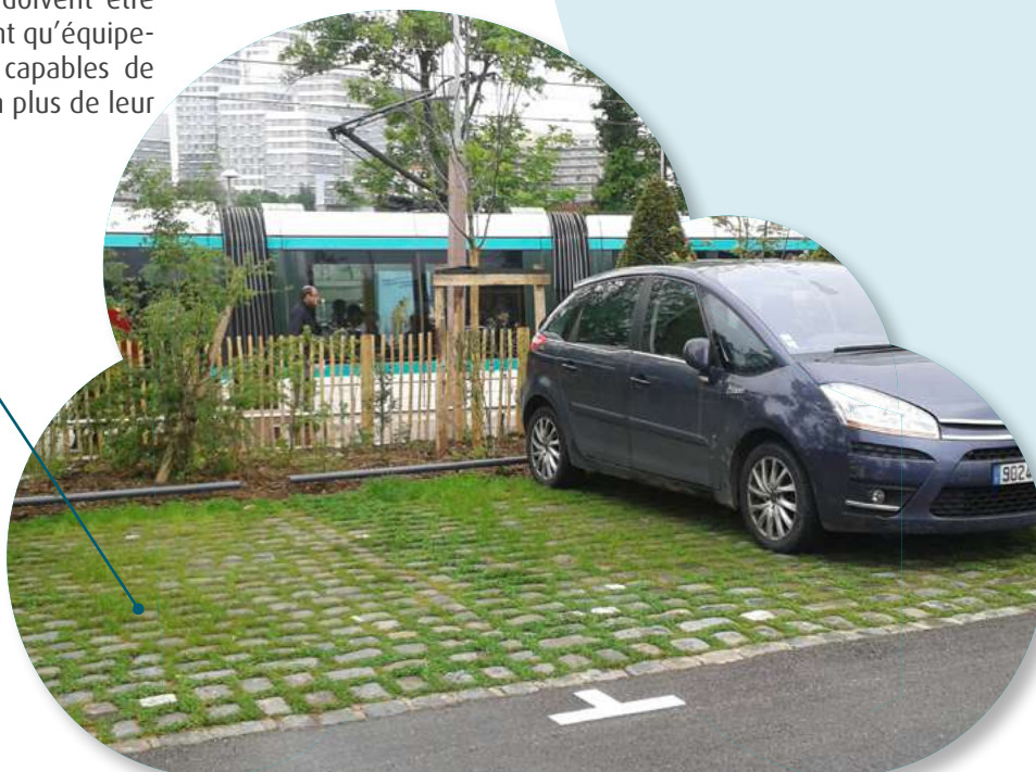
Parking infiltrant évitant l'imperméabilisation, Fresnes (DRIEE)
