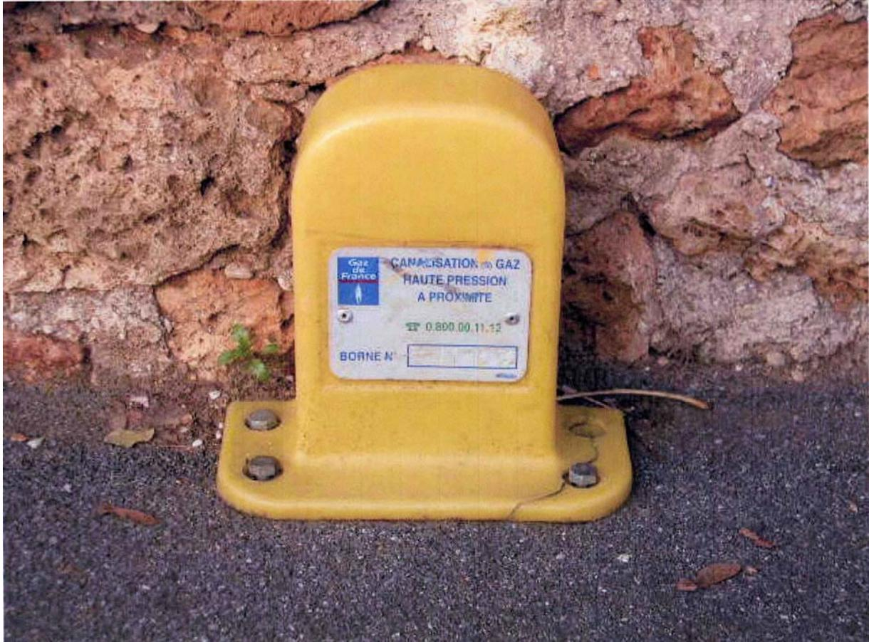
Photographie d'une borne signalant le passage de la canalisation de transport de gaz (ces bornes sont implantées sur le trottoir sur tout le parcours de la canalisation).
