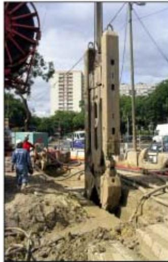
Une paroi moulée est un écran en béton armé directement moulé dans le sol.
