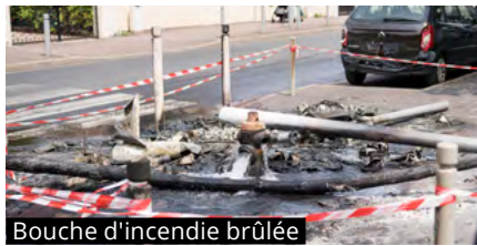
Bouche d'incendie brûlée
